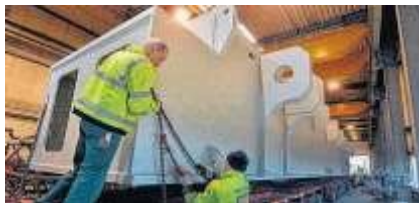
Das Bauteil wird mit schweren Ketten gesichert. FOTO: FRANK GEHRMANN
